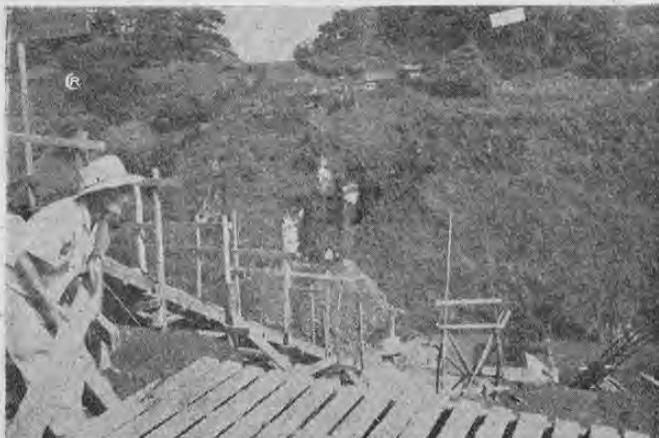
Ayer se inició la chorrea de las bases del puente en Río Segundo que es parte de la pista que conducirá al Aeropuerto de El Coco. Tendrá sesenta metros de luz y cuatro vías comprendidas en la pista. Su luz es de 15 metros. La construcción de toda la obra que comprende una extensión de 11.8 kilómetros desde el final de la Pista
