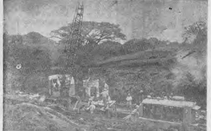
OTRO PUNTE EN LA PISTA AL AEROPUERTO INTERNACIONAL. El puente del Virilla que ya se inició su construcción, es el más largo en el trayecto que unirá la pista Wilson con el Aeropuerto de El Coco. Tiene 160 metros de luz y también comprende cuatro vias. Su altura es de 35 m., desde el nivel del agua algo así
